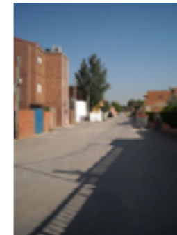
Imagen 58: Viviendas Sector 2. Fuente Informe-diagnóstico sobre la Cañada Real Galiana de FSG y Accem
