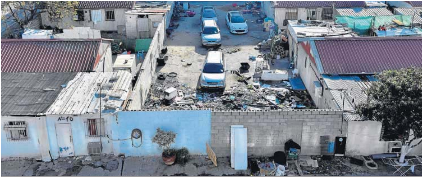
Vista de una zona deteriorada del Polígono Sur.
