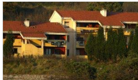
CIUDAD PROMOCIONAL. La solución para las tres familias que residen de forma irregular permitirá la demolición de los bloques. / MARIETA
