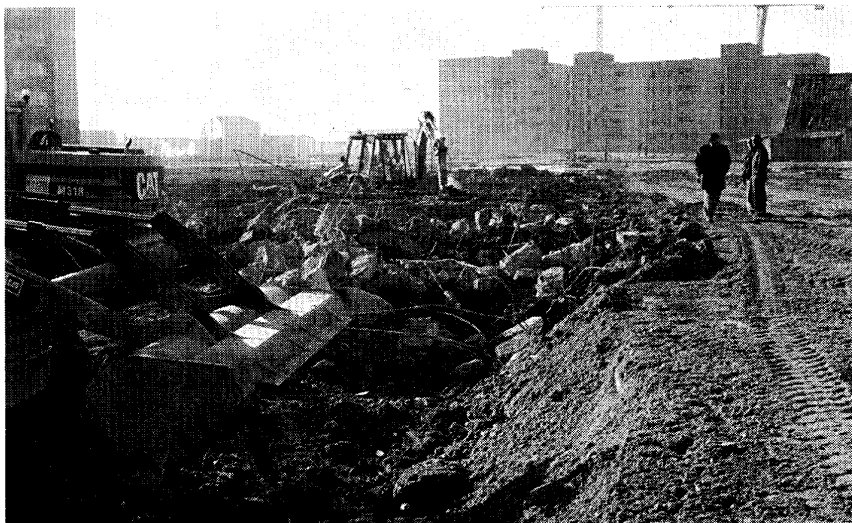
Aspecto que ofrecían ayer las obras en el solar del poblado, con la última casa al fondo a la derecha. / H. SASTRE
